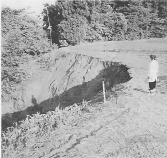
県道・湯上―北山線は5月31日深夜・稗苗地内で土砂くずれが発生し（＝写真）、夜を徹しての復旧工事でようやく開通した。恒久的な対策が待たれる
